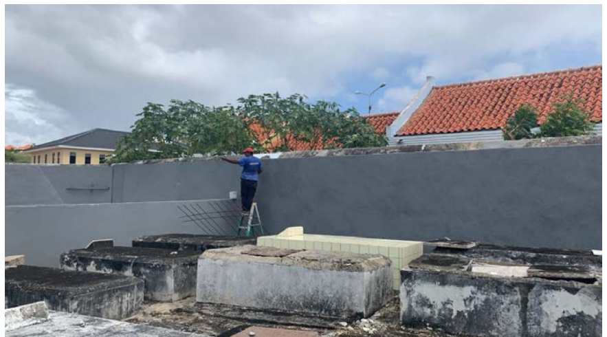
Wekzaamheden muur Oranjestraat
